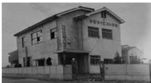
写真2 昭和25年頃復興、完成した鶴舞公園前の校舎
