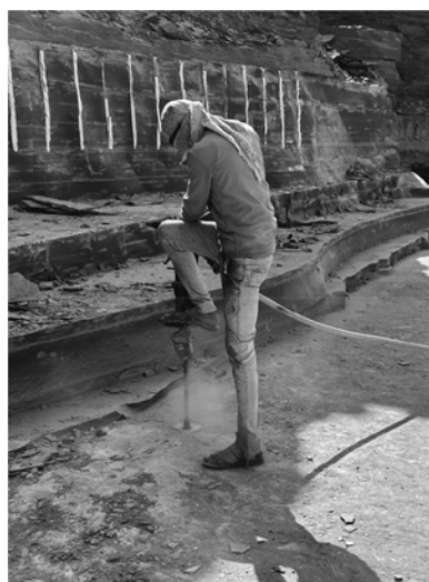
写真2 粉塵への暴露を減らすために、散水と適切なマスクの使用が提案されました。
