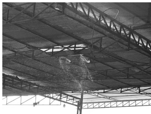
写真2 臭気と粉塵を軽減するために天井に取り付けられた香料入りの散水装置。
