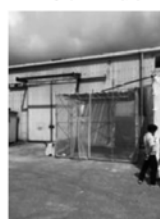
ビニール養生
