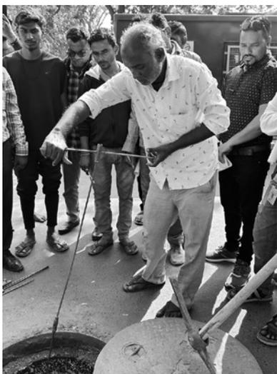
写真2 回しながら汚泥を攪拌して取り出しやすくします。
