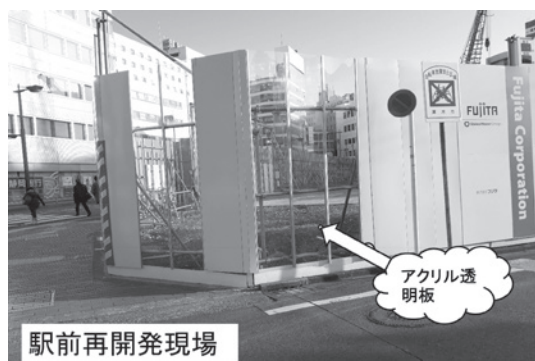
写真1 覆うとフェンスを壊されるので、積極的に見せるという工夫
