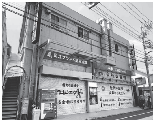
写真1 株式会社横引シャッター社屋
