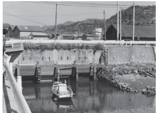
写真4 チッソが廃液を1953年から1958年まで排出した百聞川の排出口。板で封じてある (1985年4月)。
