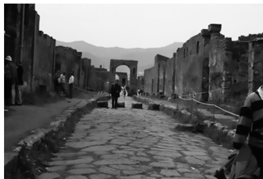
写真6 飛び石を設置した道路
