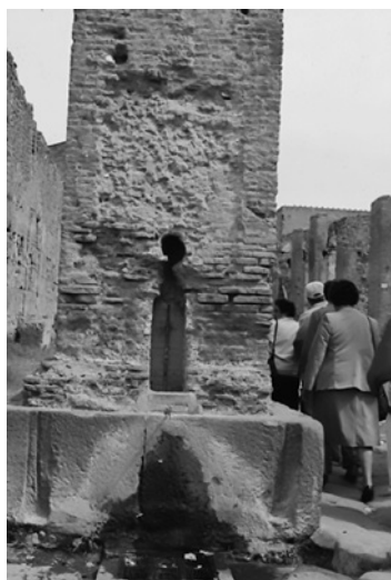
写真3 鉛製の水道管
