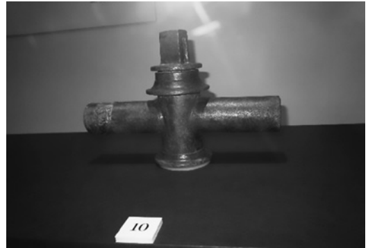
写真10 水道の弁
