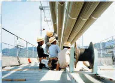
1985年 本四架橋工事落下防止調査
