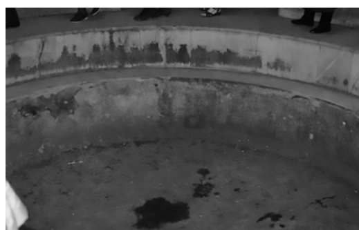
写真5 公衆浴場の底面
