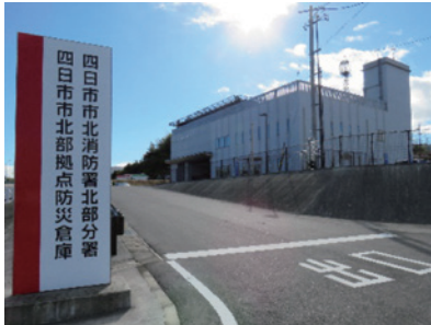
▲庁舎出入口からの全景
