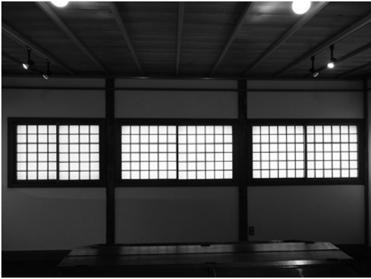
写真4 障子引き違い窓
