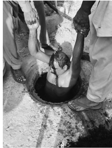
写真2 マンホール内での作業を終わったシャヒーさんを外の仲間が引き上げます。
