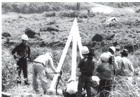
写真4 最初の「三角すい」設置作業の風景（左端は筆者）
