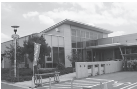
写真1 フレビアの外観
