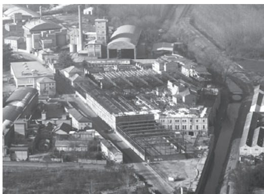
写真1 エタニット社のカザーレ工場（解体前）
