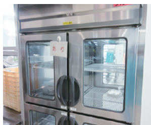
▼パススルー冷蔵庫を衛生区分を明確にした区域の境に設置
