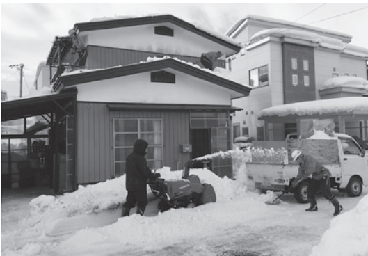
写真3 住宅密集地での雪捨て作業
