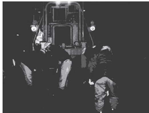
写真7 トンネル内の保線作業
