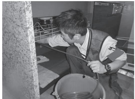
写真1 専有部（台所）の洗浄作業
