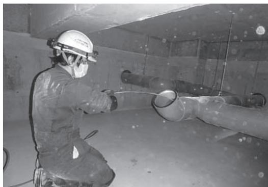
写真3 共用部(地下ピット内共用横主管)の洗浄作業
