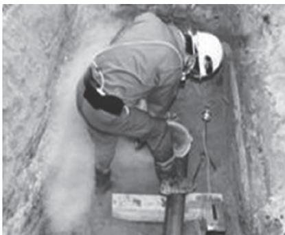
写真3 水道管をエンジンカッターで切断
