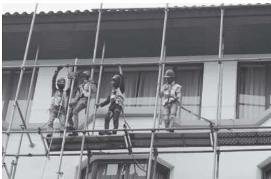
写真4 建設現場で安全帯とヘルメットを着ける作業 者
