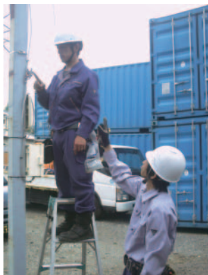
▲安全第一優先の電気工事
