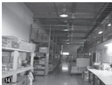
⑬照度測定を実施 ⑭水銀灯を交換
