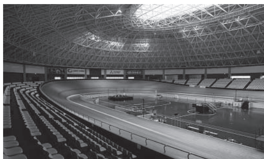
写真2 屋内型自転車トラック競技施設 「伊豆ベロドローム」
