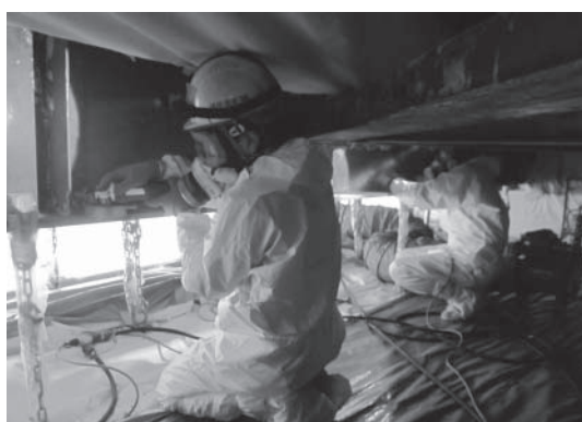
写真7 鉛含有塗料かきとり
