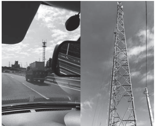
写真1 携帯電話基地局の電波塔
