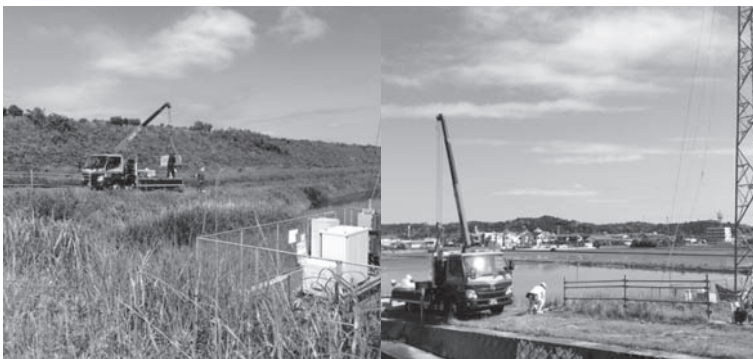
写真2 重量物運搬・設置作業
