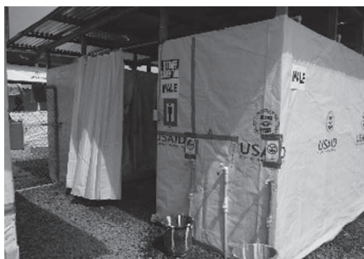
図3 エボラ治療ユニット内の簡易トイレの入り口：手洗いは0.05%次亜塩素酸ナトリウム消毒液の蛇口（青）と、手洗い以外に利用する0.5%次亜塩素酸ナトリウム消毒液（赤）の蛇口に分かれている。
