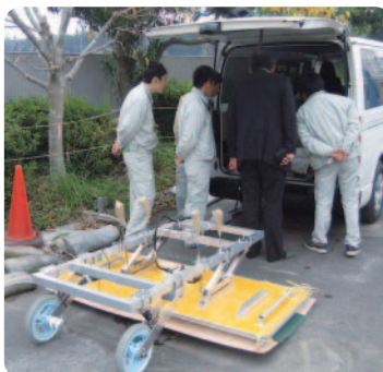
▲3次元地中レーダによる探査
