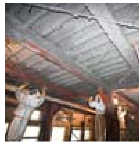
写真3 吹付け石綿除去作業
