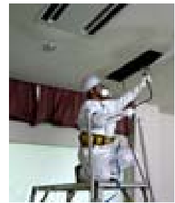
写真4 天井板除去作業
