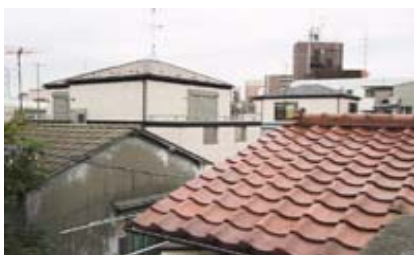
写真1 この中に石綿含有の可能性がある建材が3種類あります
